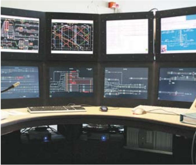
**In den Jahren 1993 bis 1995 wurde der Bahnhof Wörgl mit einem Aufwand von rund 100 Millionen Euro (1,4 Milliarden Schilling) von den Österreichischen Bundesbahnen fast vollständig umgebaut und mit der damals modernsten Zentralstellwerksanlage ausgestattet, die laufend weiter ausgebaut wurde. Bild: Einer der drei Kommandotische der heutigen Zentralstellwerksanlage in Wörgl Hbf.**
