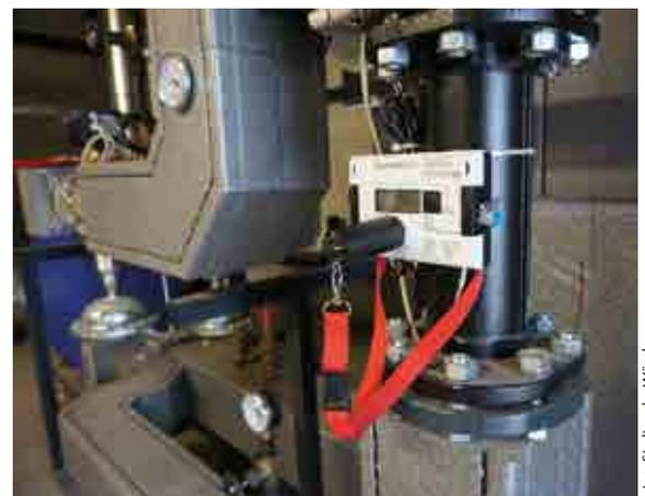
Wärmehähler eines Privathaushaltes (links) und der Spar Zentrale in Wörgl, die im Zuge der fünfjährigen Wartungsintervalle getauscht und geeicht werden.
