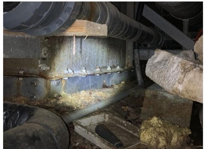
Foto 50: Dahinter korrodieren unzugänglich Becken und Tragkonstruktion
