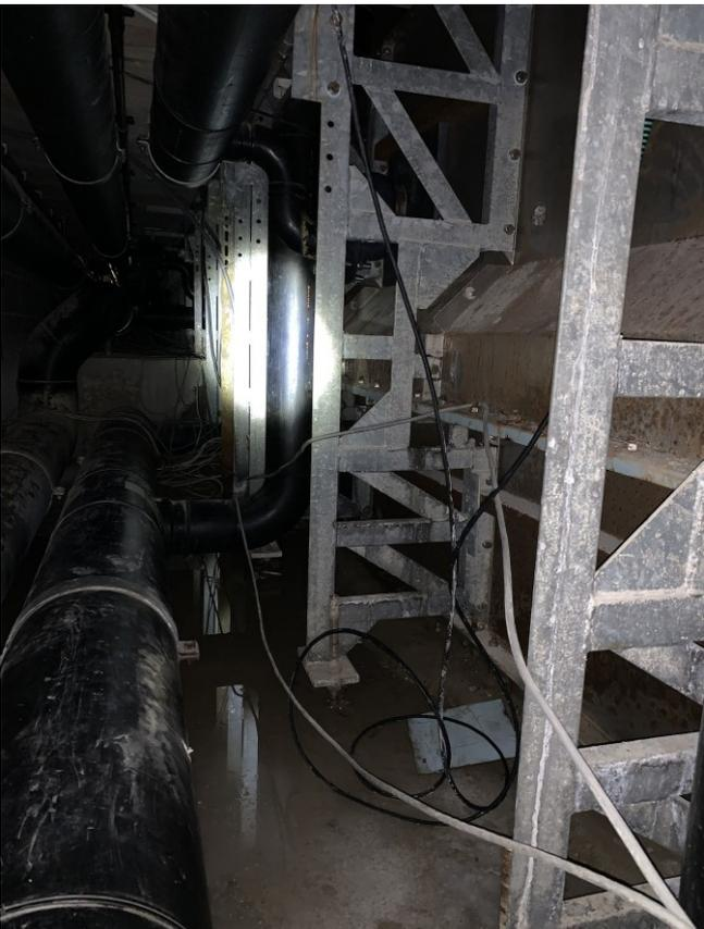
Foto 109: Korrodierte Becken und Tragkonstruktionen im stehenden Wasser
