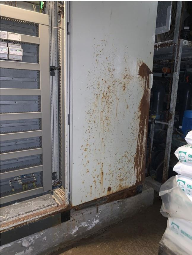
Foto 115: Innenseite einer korrodierten Elektro-Verteiler-Schranktür
