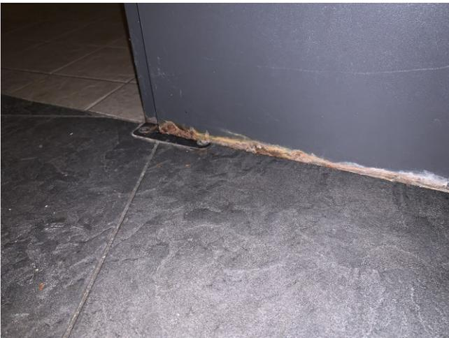
Foto 65: korrodierte Türblätter Brandschutztüren
