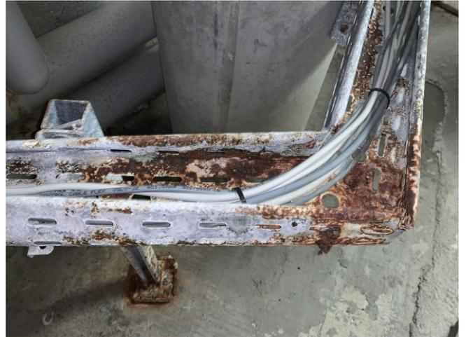
Foto 118: Nässe und korrodierte Kabelführungen
