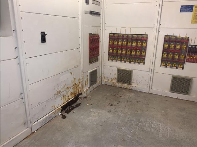
Foto 117: Durch ständige Nässe korrodierte Schaltschränke
