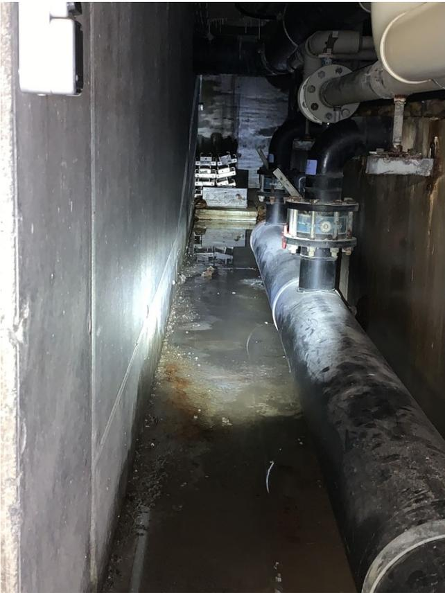
Foto 100: stehendes Wasser in schwer zugänglichen Schwimmbad-Technikbereichen, Materiallager(?)
