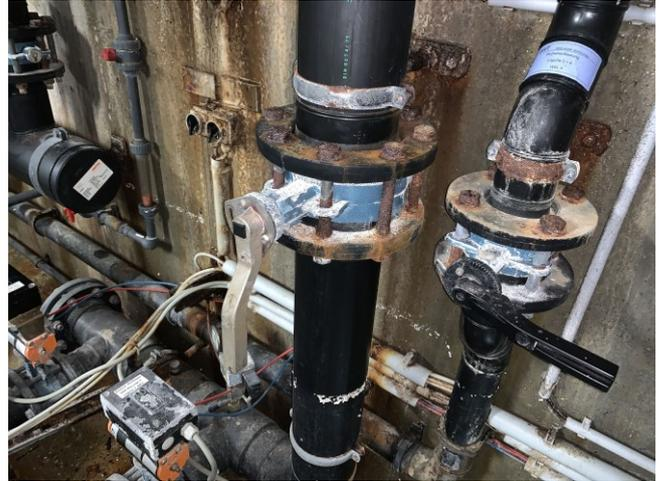
Foto 99: Wasser läuft über elektrische und mechanische Schwimmbad- und Steuertechnik
