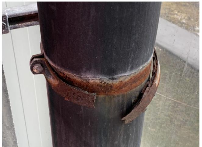
Foto 12: Durchkorrodierte Rohrschellen
