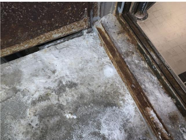
Foto 62: Stark korrodierte Einstiegsluke zum Saunabereich, abgelagerte Salze aus Nässe
