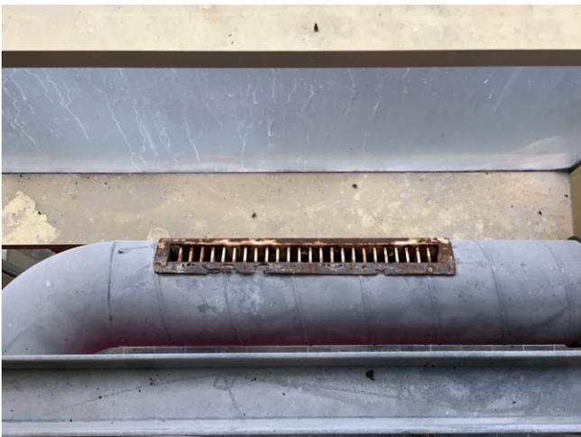
Foto 11: Korrodierte Lüftungsteile
