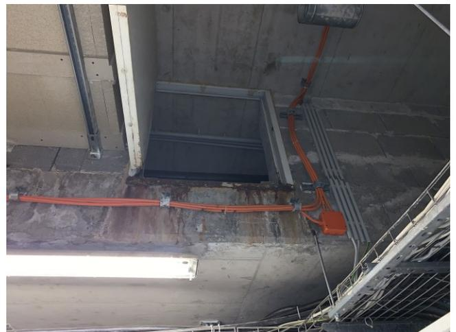
Foto 62: Eine weitere durch andauernde Einwirkung von Badewasser stark korrodierte Luke
