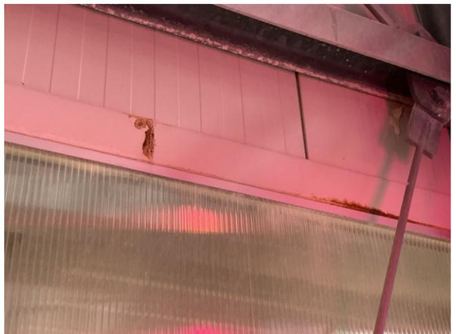
Foto 18: Korrodierte Metallpaneele
