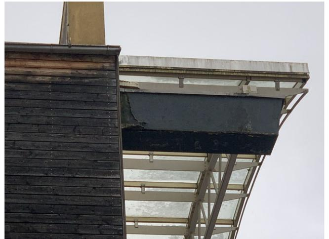
Foto 2: Bei Regen rinnt Wasser über Fassade und Rinnenverkleidungen - in großer Menge läuft die gänzlich defekte Rinne über
