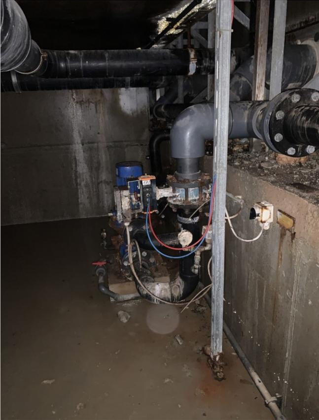
Foto 103: an allen Teilen korrodierte Anlagentechnik
