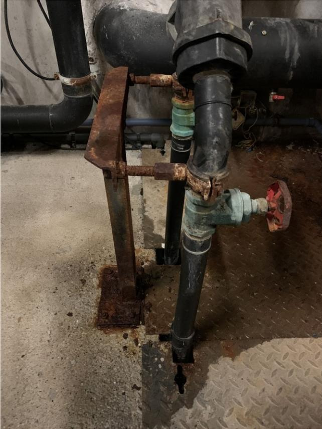
Foto 93: Korrodierte Tragkonstruktionen und Steig-Rohre aus dem Pumpenschacht
