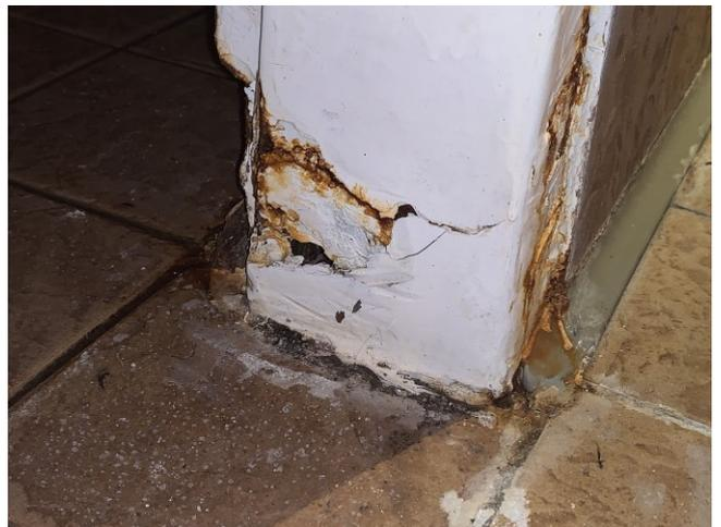
Foto 66: korrodierter Türstock, kaputter Fliesenbelag und Fugen
