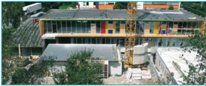
Kindergarten Mitterhoferweg im Umbau.
