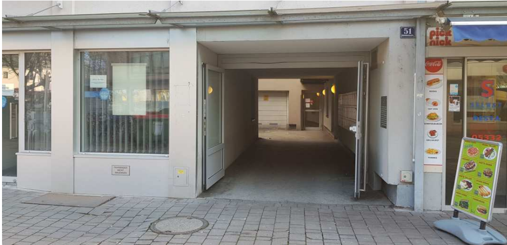
Abb. 7: Zufahrt Innenhof HNr. 51 (2 Pkw-Garagen)
