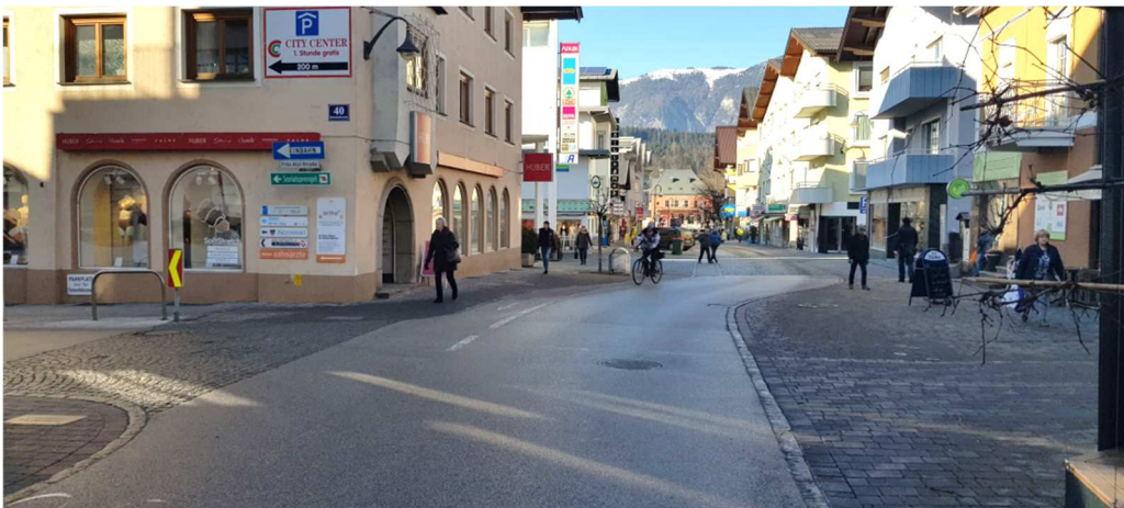
Abb. 2: Beginn der geplanten Fußgängerzone, links die Abzweigung in die Fritz-Atzl-Straße
