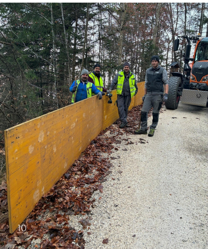
Foto: Bauhof Wörgl | Ladstätter
