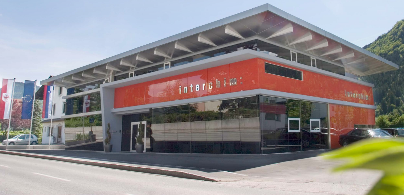
Firmengebäude – Wörgl, Brixentaler Straße 67
