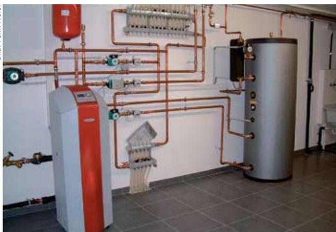
Grundwasser-Wärmepumpe (li) mit der Warmwasseraufbereitung (re)
