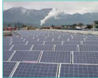
294 Solarwatt-Module mit 30 Grad-Aufständigung
