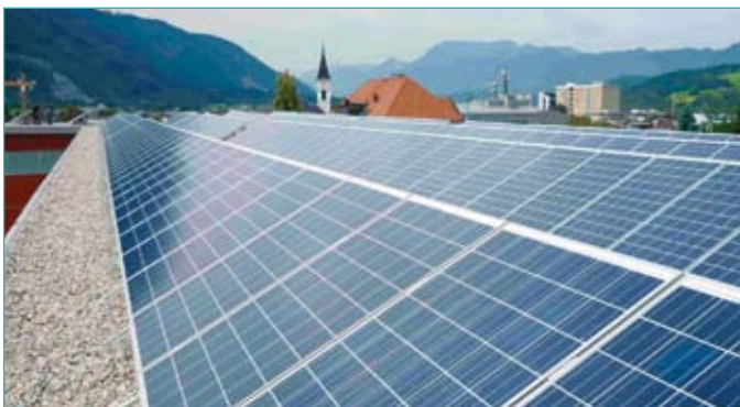
Mit knapp 40 Anlagen ist Wörgl der Vorreiter für Photovoltaik in Tirol – hier die Großanlage auf dem Dach der Volksschule.
