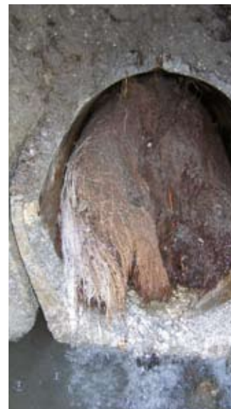
Fotos: Stadtwerke Wörgl
