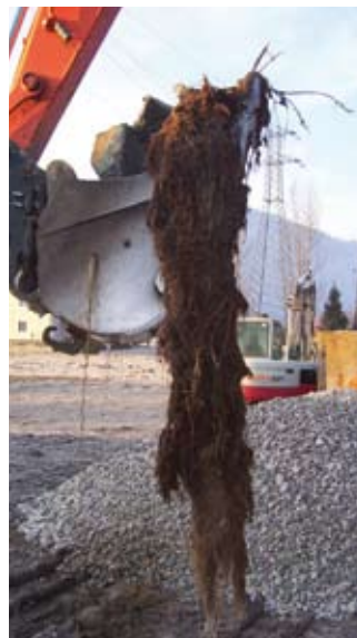
Aushubarbeiten zur Sanierung des Kanals.
