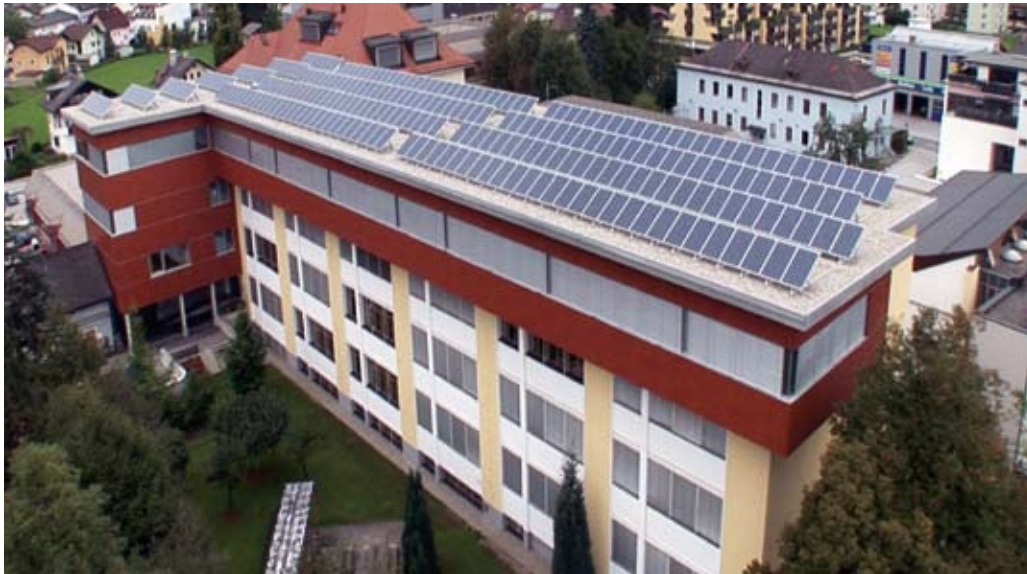
Photovoltaikanlage bei der Volksschule Wörgl.
