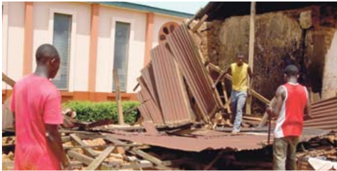
Abbruch der alten Behausung.
