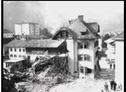
Abbruch des Angeli-Hauses, ca. 1972
