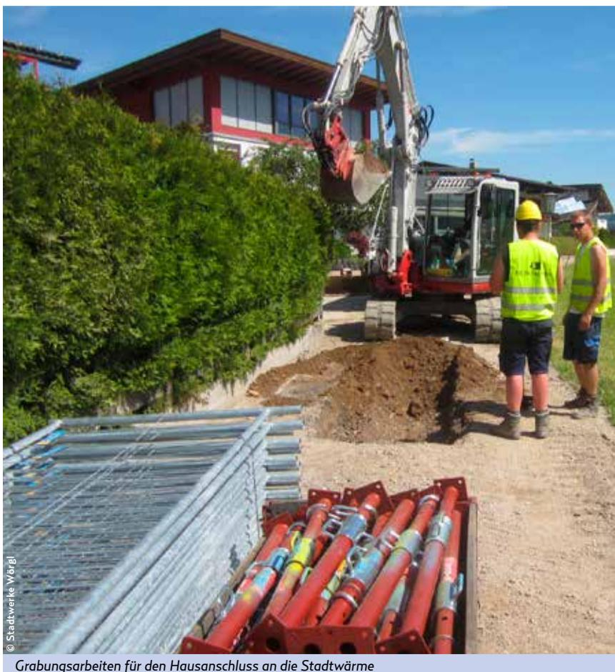
Grabungsarbeiten für den Hausanschluss an die Stadtwärme
