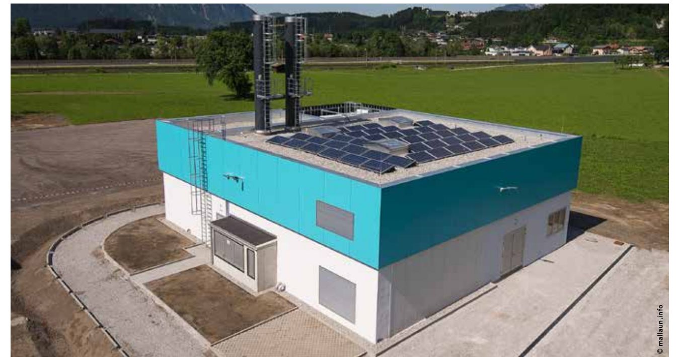
Sonnenkraftwerkspark IV am Dach der Energiezentrale
