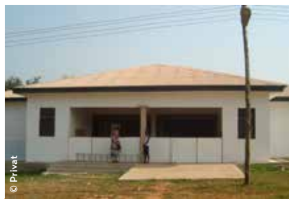
Die neue Krankenstation präsentiert sich außen schon fast fertig.
