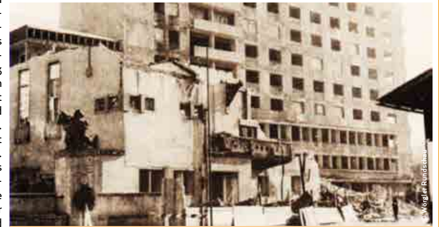
Abbrissarbeiten mit dem Krieger Denkmal im Vordergrund
