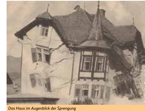
Das Haus im Augenblick der Sprengung
