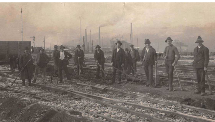
Arbeiter beim Gleisbau
